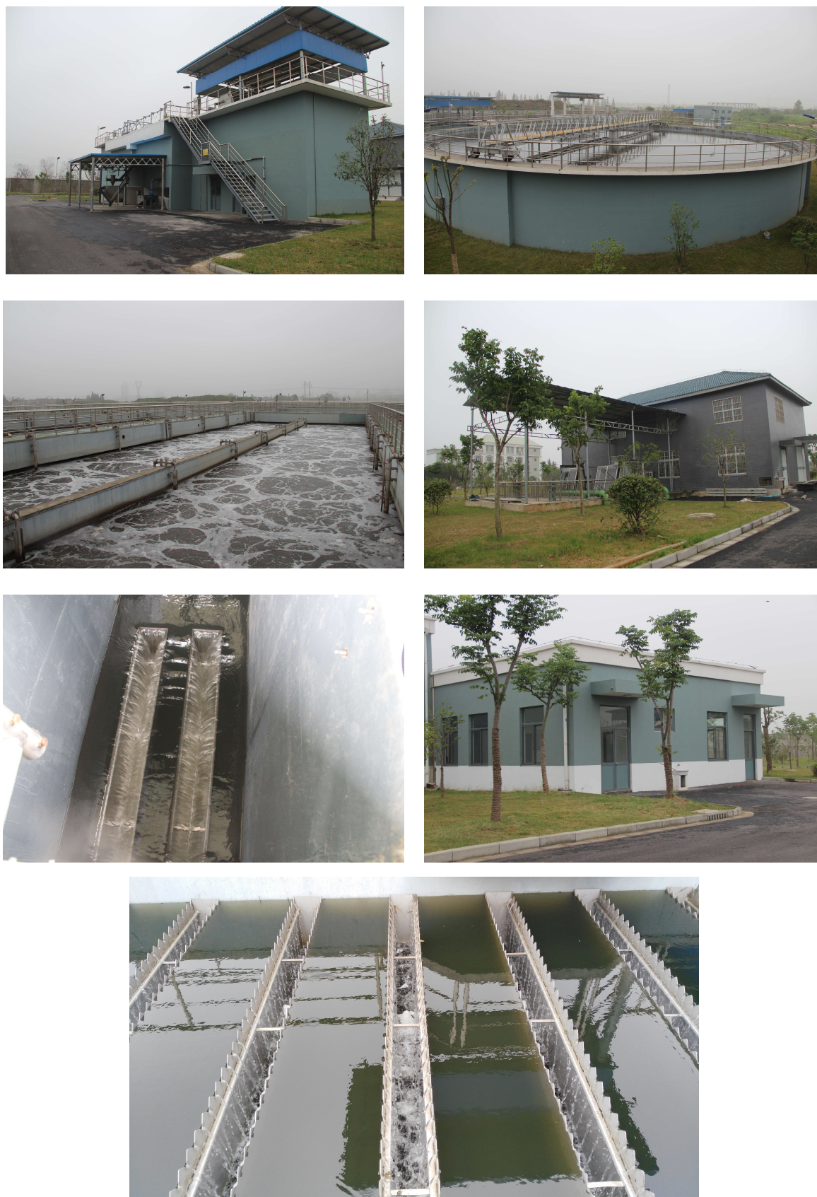
图 3-1 厂区生产设施
