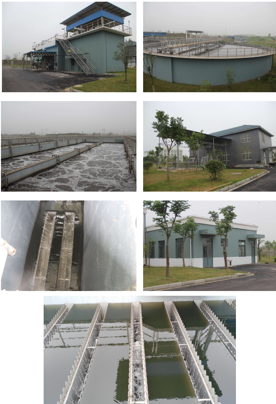
图 3-1 厂区生产设施
